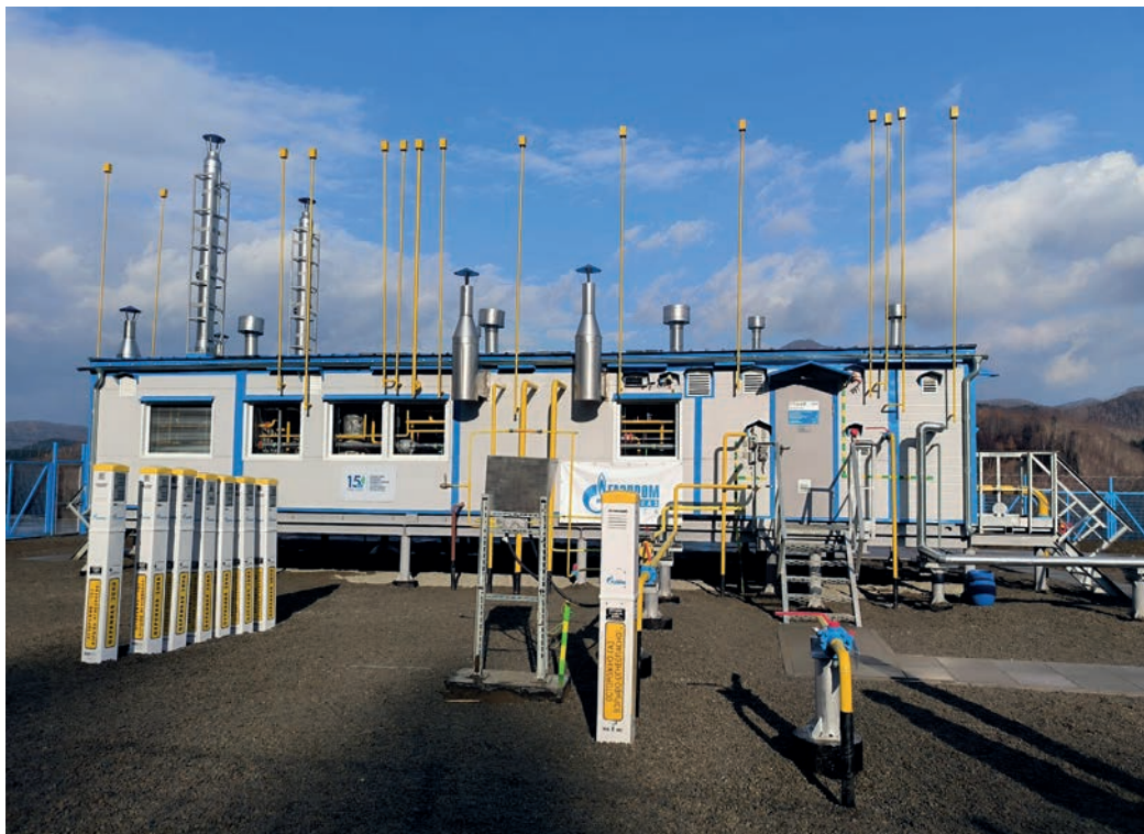
На ГРС «Макаров» продолжаются пусконаладочные работы
