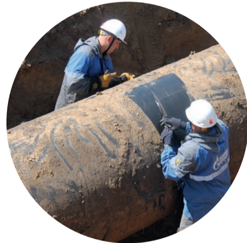
Замена дефектного участка трубы в зоне ответственности Омского филиала ООО «Газпром трансгаз Томск»
