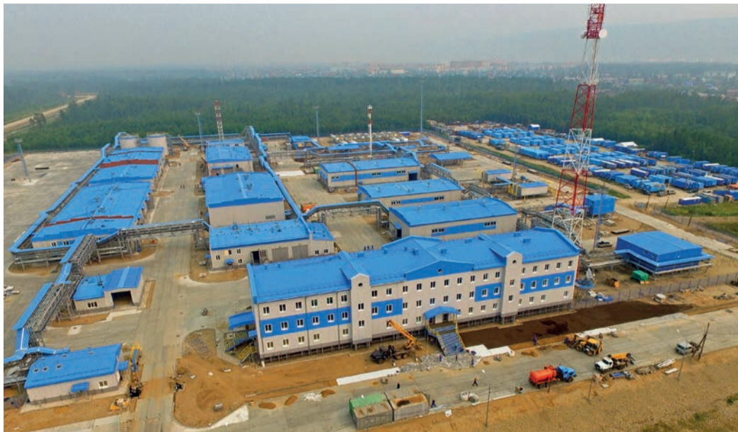
2019 год: завершающий этап строительства базы Ленского линейного производственного управления магистральных газопроводов
