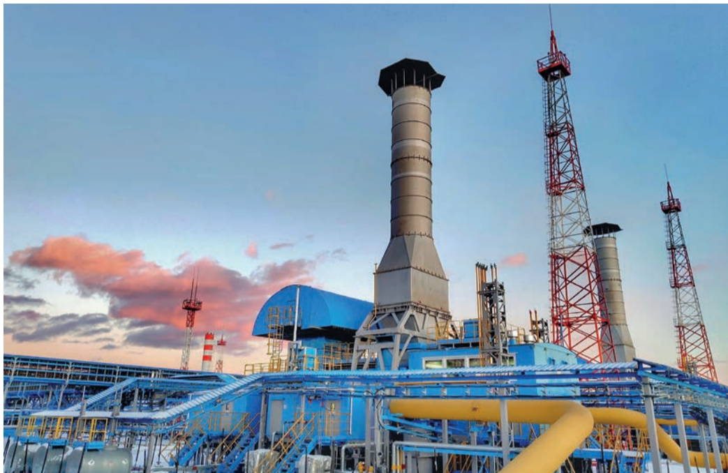
На компрессорной станции «Ерофей Хабаровов» ведется строительство второго цеха
