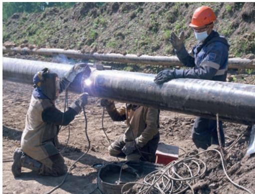
Сварка стыка газопровода-отвода к ГРС-2 г. Новосибирска
