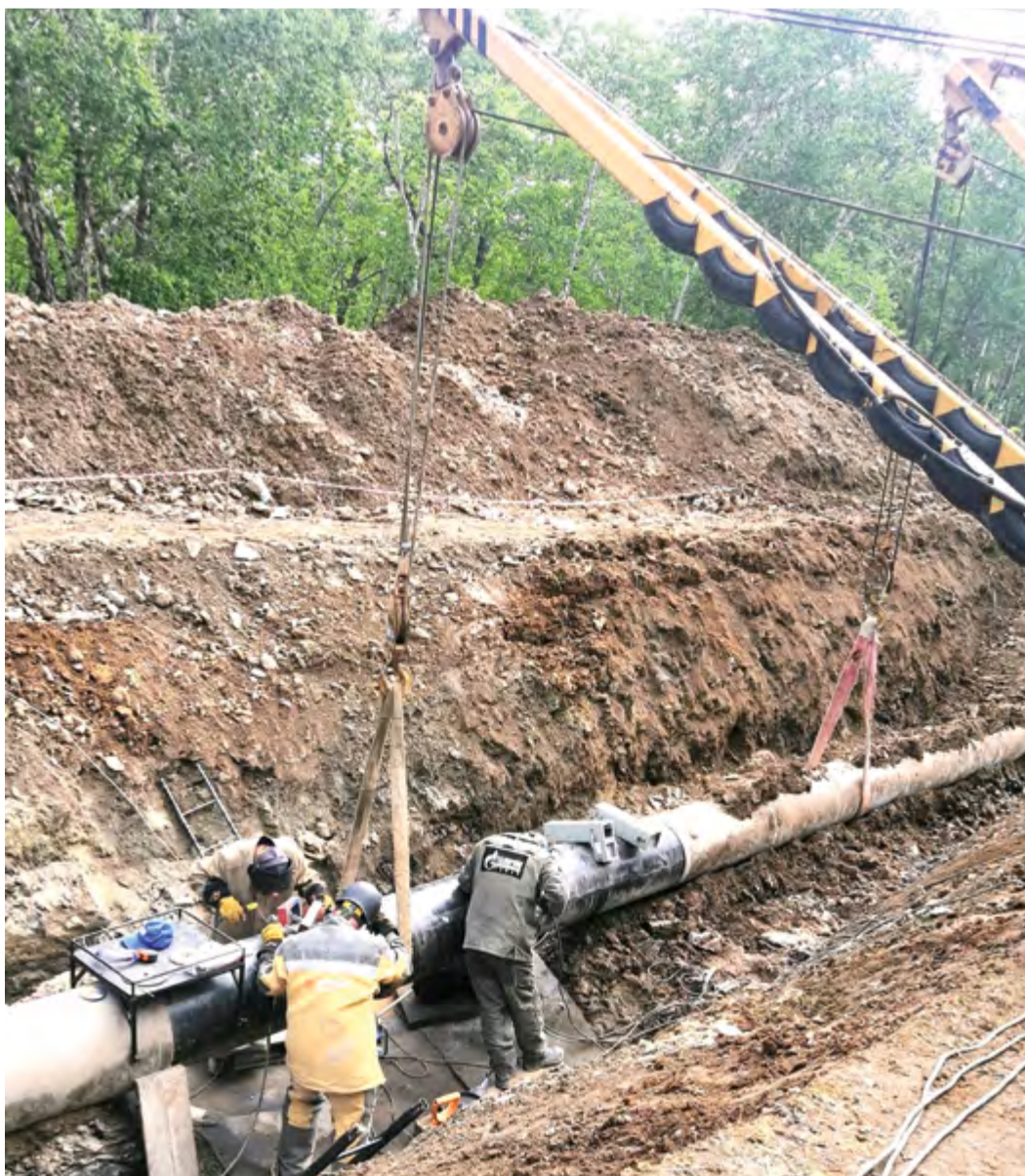
Огневые работы на магистральном газопроводе УКПГ Нижне-Квакчикского ГКМ – АГРС г. Петропавловска-Камчатского
