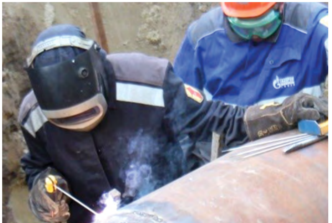
Замена дефектного участка на МГ Новосибирск – Барнаул
