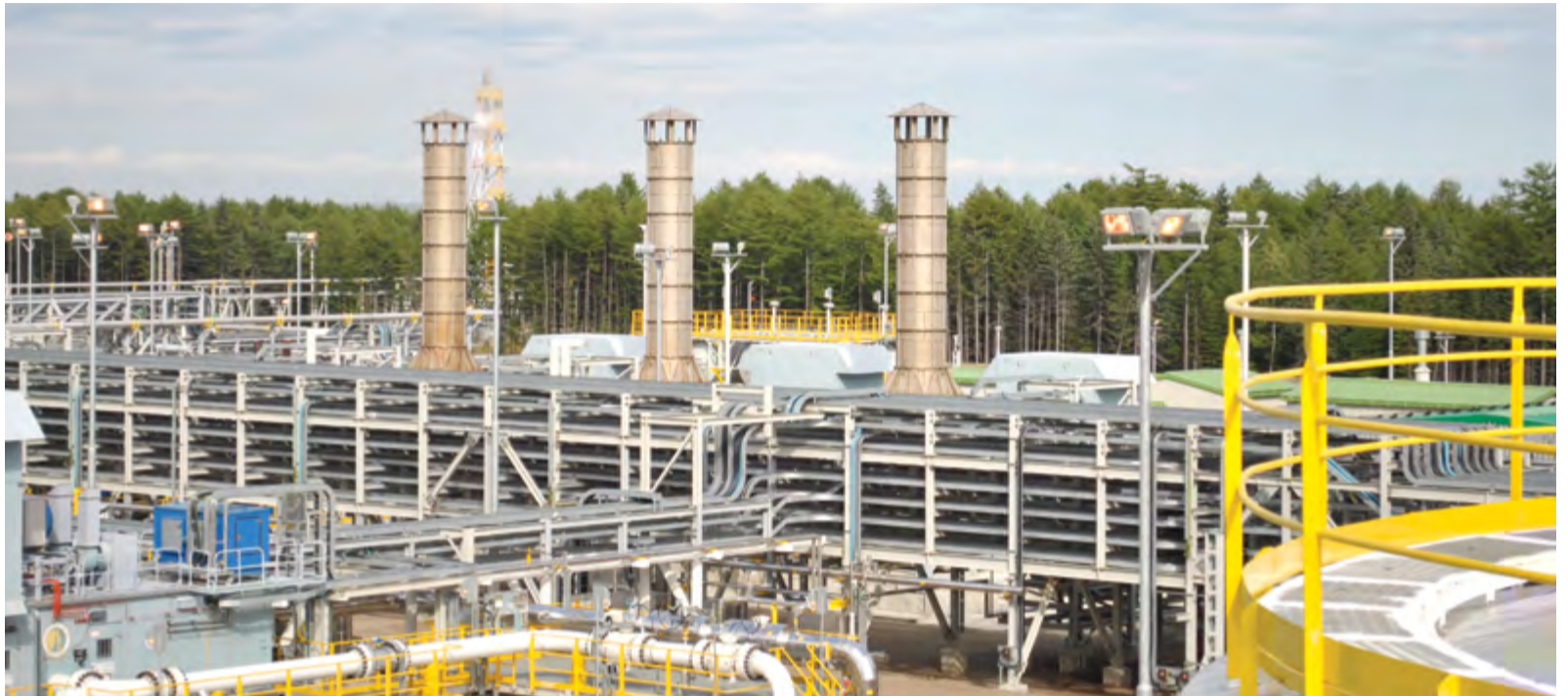
Общий вид насосно-компрессорной станции № 2 проекта «Сахалин-2» / Фотография предоставлена «Сахалин Энерджи»
