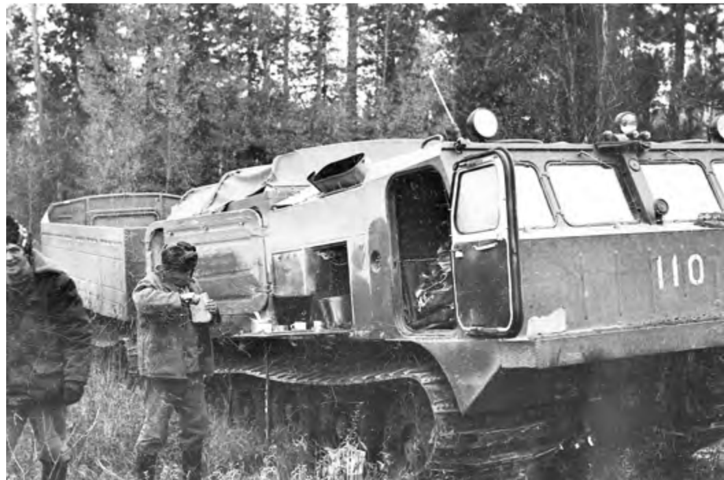
Строительство газопровода Нижневартовский ГПЗ – Парабель – Кузбасс
