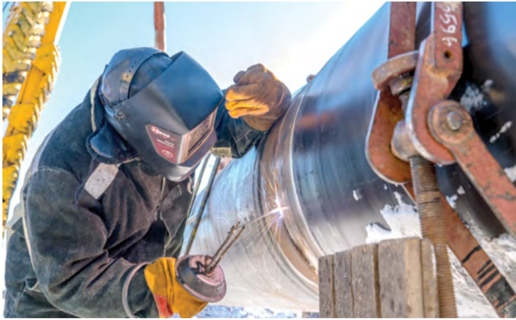
Каждый год в зоне ответственности Александровского ЛПУМГ проходят масштабные огневые работы
