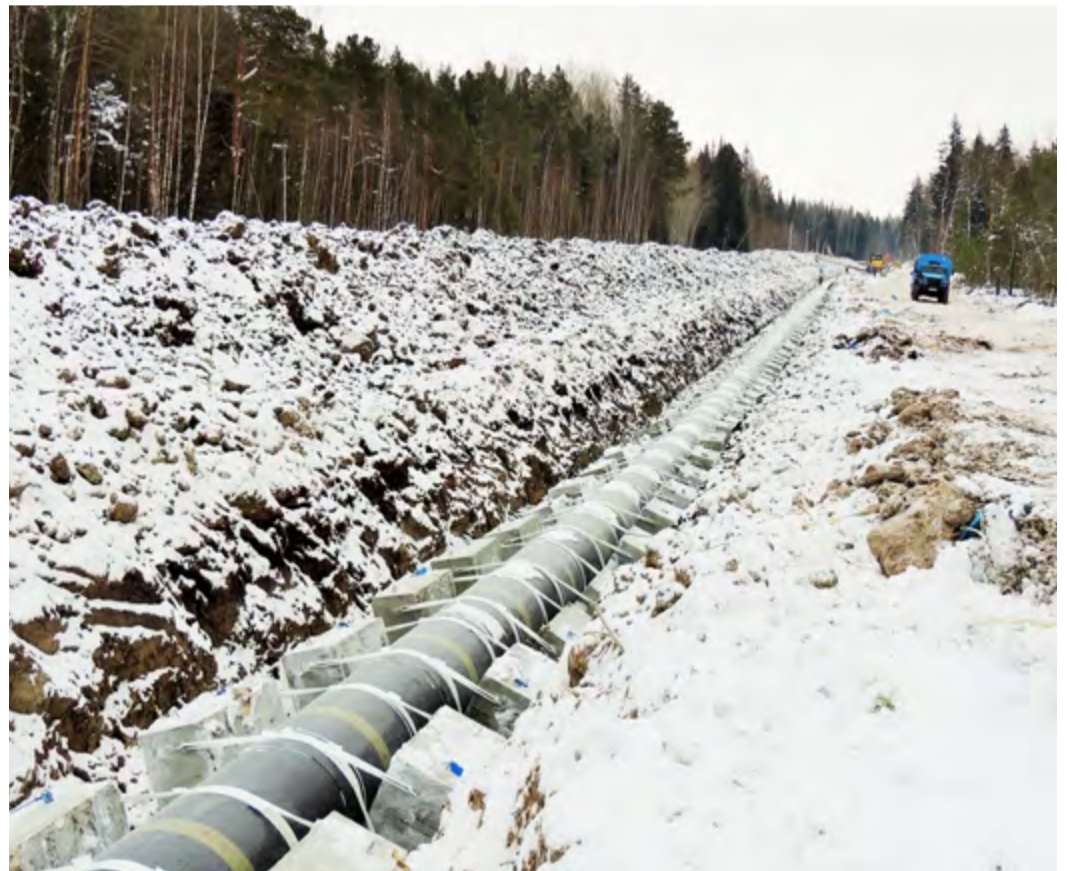
Бетонные балластирующие устройства удерживают трубу в земле от всплытия
