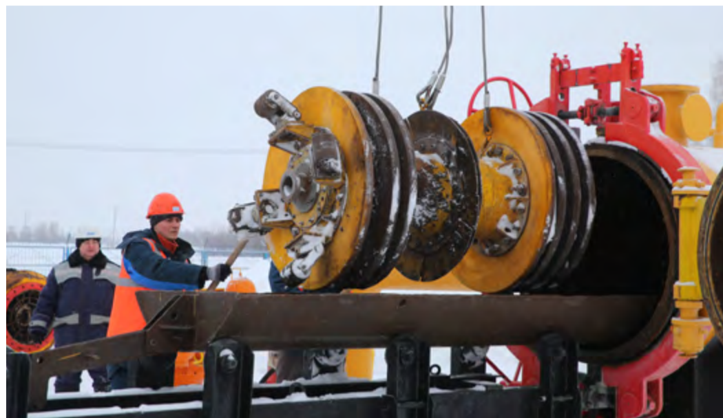
Специалисты Юргинского ЛПУМГ запускают очистной скребок
