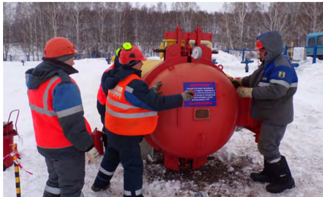
Сотрудники Кемеровского ЛПУМГ готовы к приему поршня
