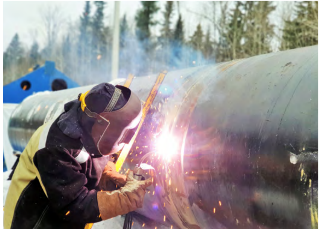
Этой зимой на газопроводе ПарABELь – Кузбасс вновь меняется протяженный участок трубы
