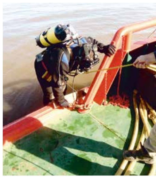
При обследовании подводных участков газопровода водолазы выполняют контрольные осмотры
