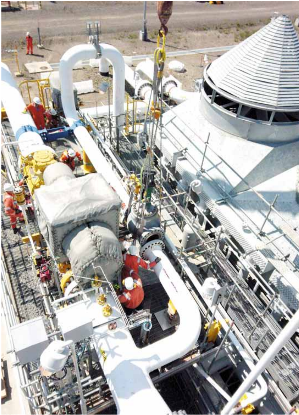
Грузоподъемная операция по замене антипомпажного клапана газоперекачивающего агрегата
