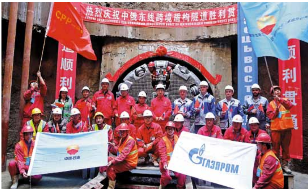
Торжественное завершение тоннельной проходки основной нитки подводного перехода
