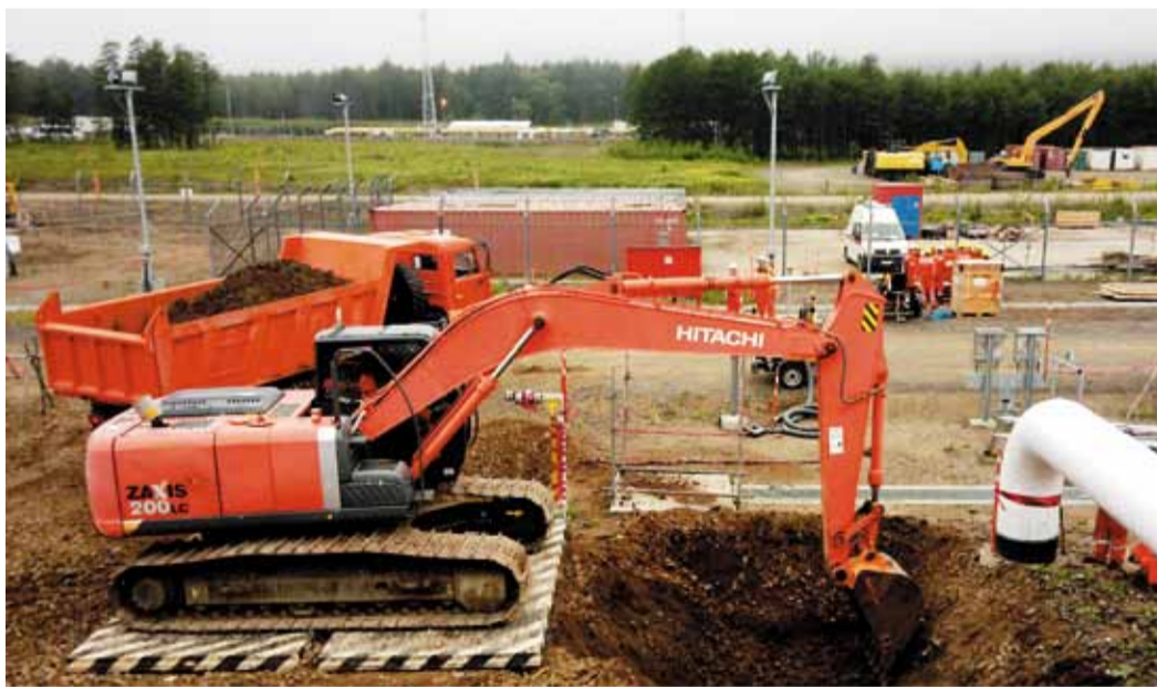
Подготовка демонтажа дренажных линий входного и выходного коллектора газоперекачивающих агрегатов
