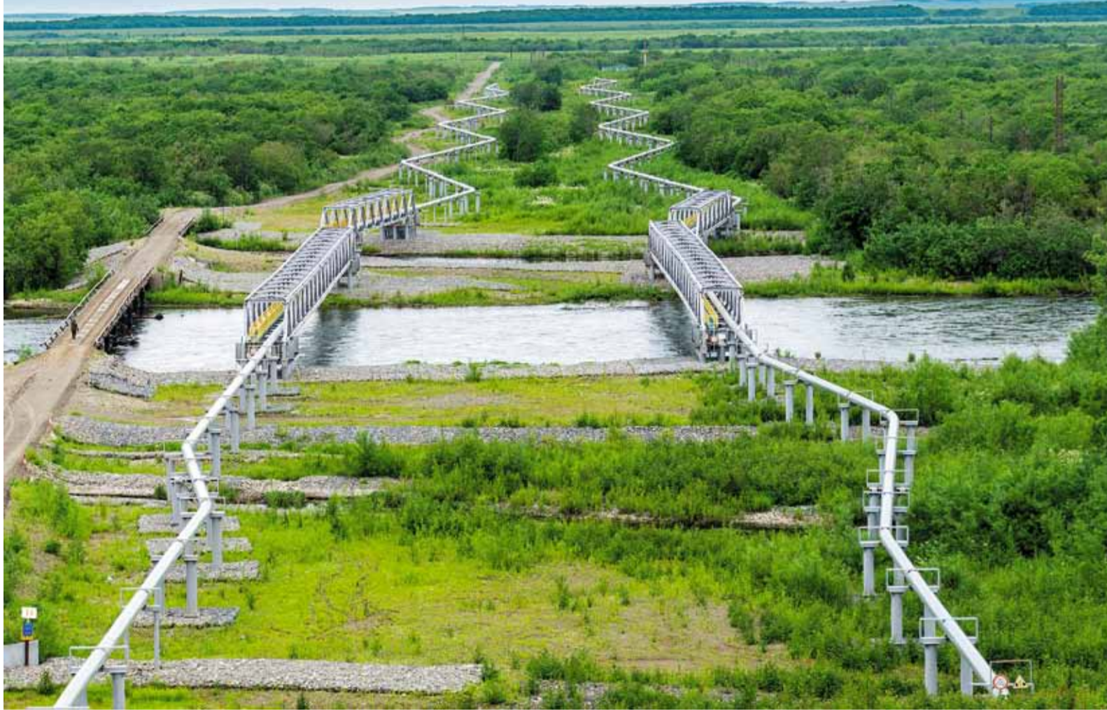
На Камчатке все 33 перехода газопровода через реки выполнены в надводном исполнении
