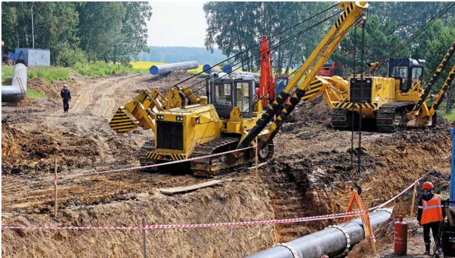
В этом году Кемеровское ЛПУМГ провело масштабные огневые работы. На некоторых объектах кемеровчанам помогли бригады УАВР
