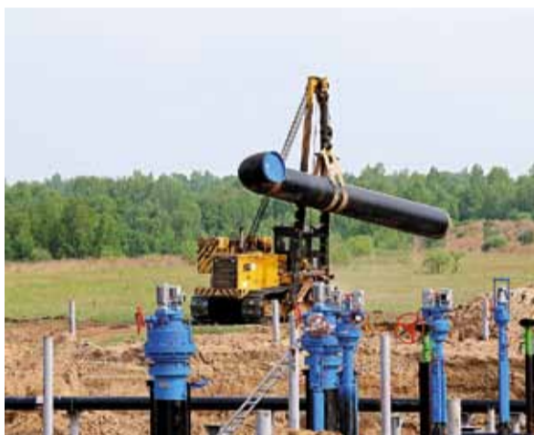
Строительство газоизмерительной станции
