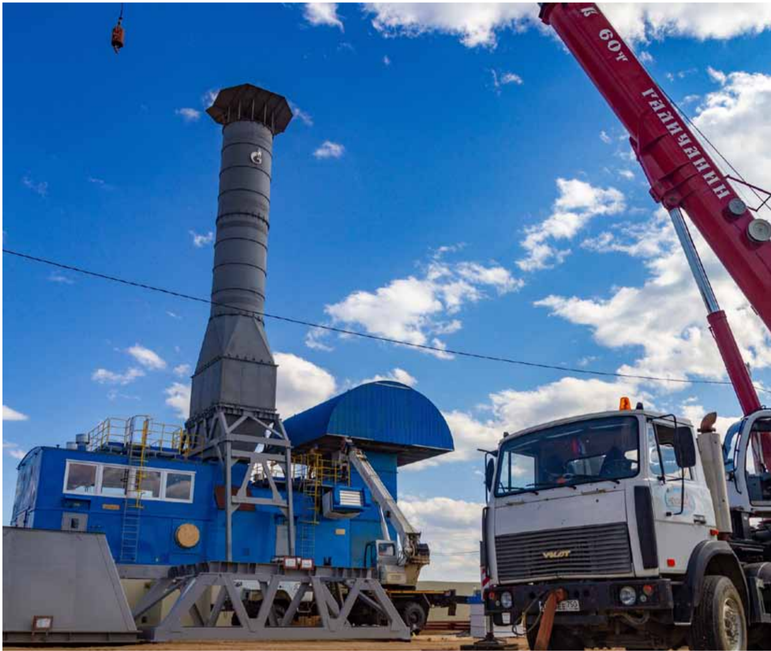
ГПА-16У на строящейся КС «Зейская»
