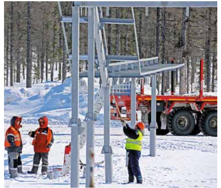
Работы на крановом узле
