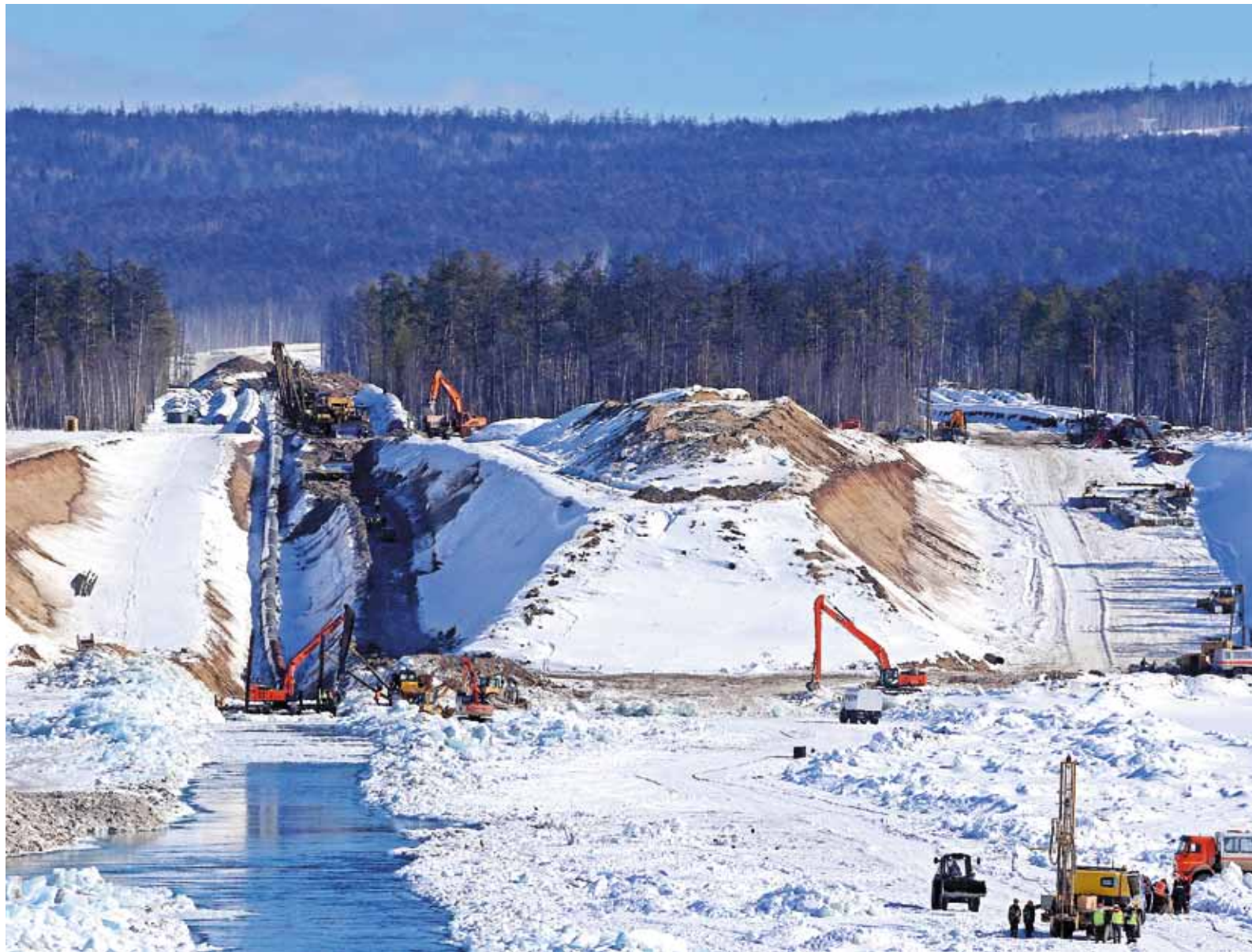
Переход через Лену – самый протяженный подводный переход в зоне ответственности «Газпром трансгаз Томск»
