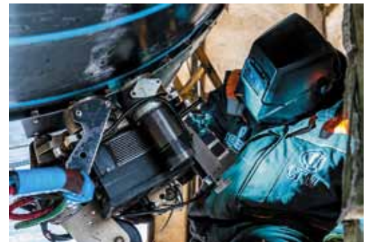
Сварщик автоматического комплекса контролирует процесс сварки
