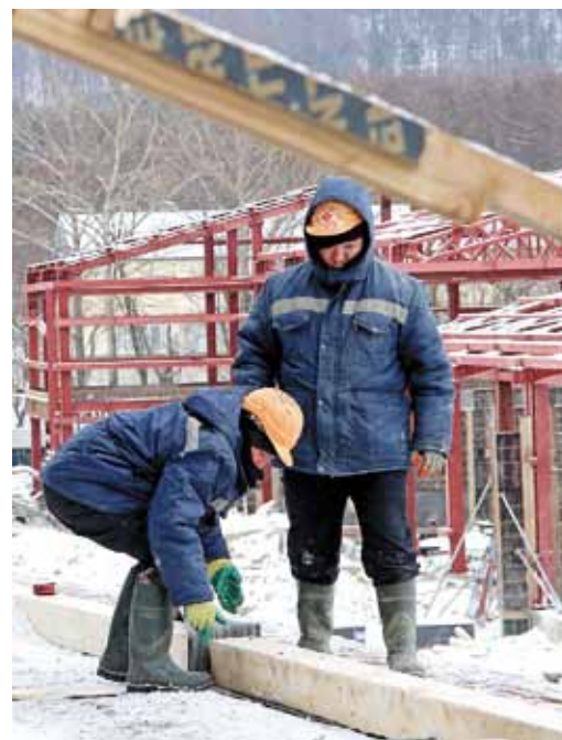
Установка маурлата на крыше объекта
