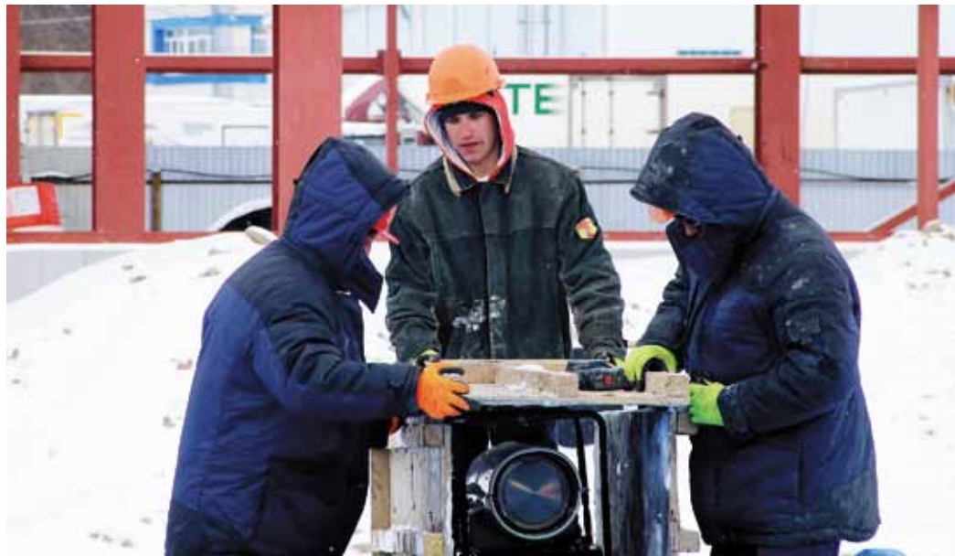
Монтаж теплового контура для зимнего бетонирования
