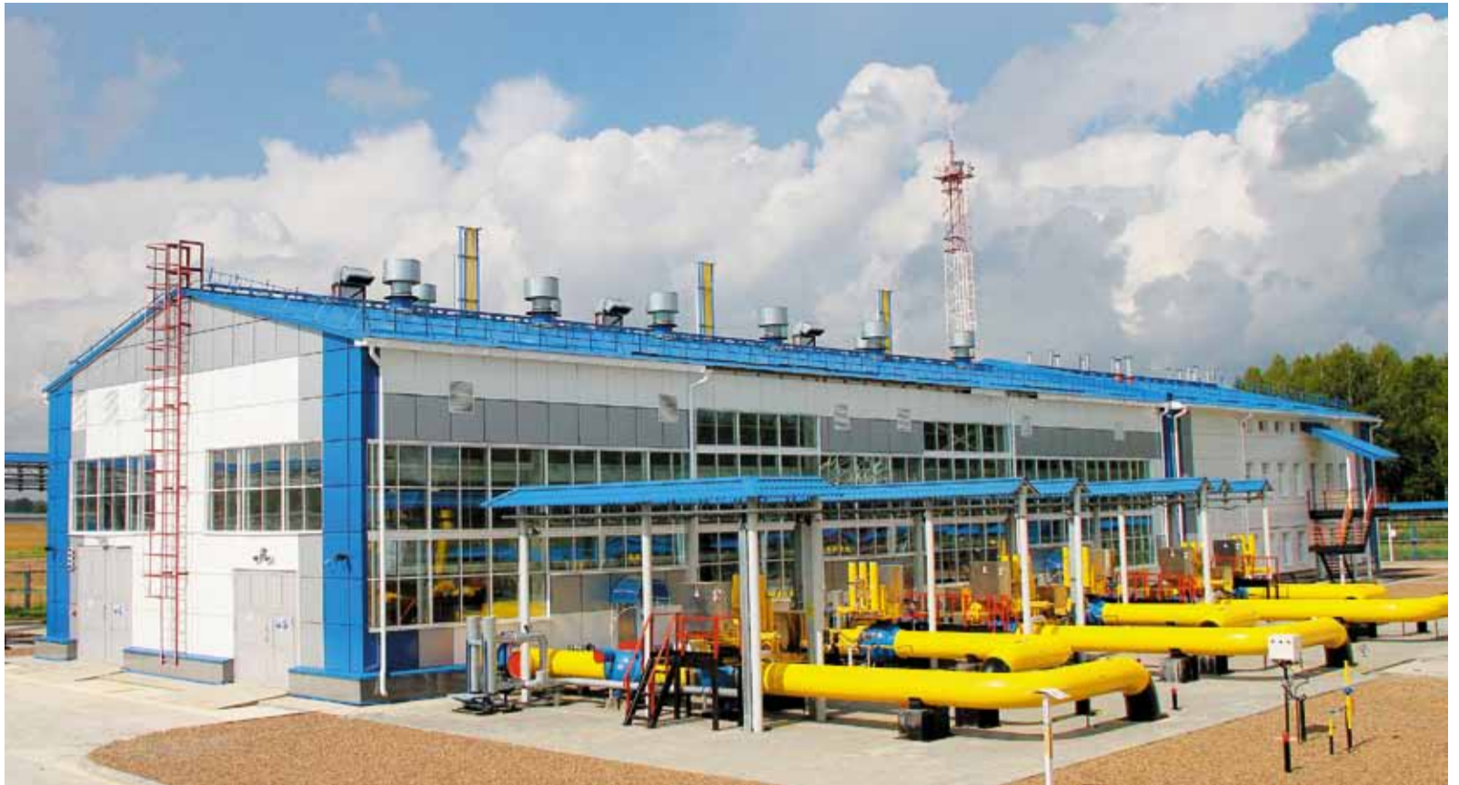
КС «Просоково» после реконструкции
