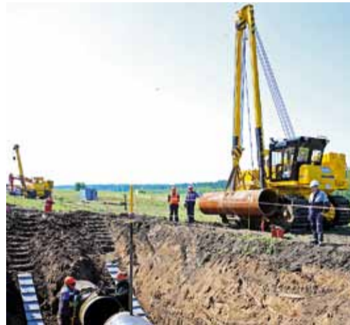
Огневые работы на территории ответственности Юргинского ЛПУМГ
