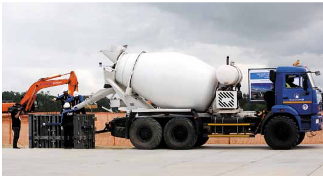
Заложено первое фундамент Амурского ГПЗ. Фото РИА «Новости»
