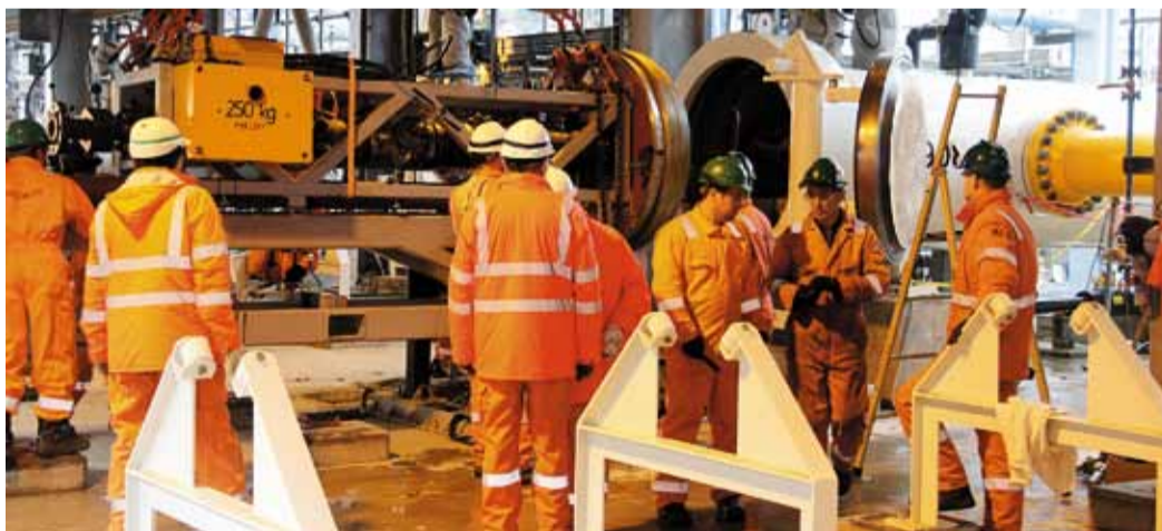
Единая команда ОБТК в ходе выполнения работ на объекте
