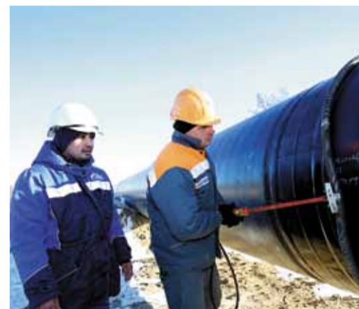
Проверка сплошности изоляционного покрытия
