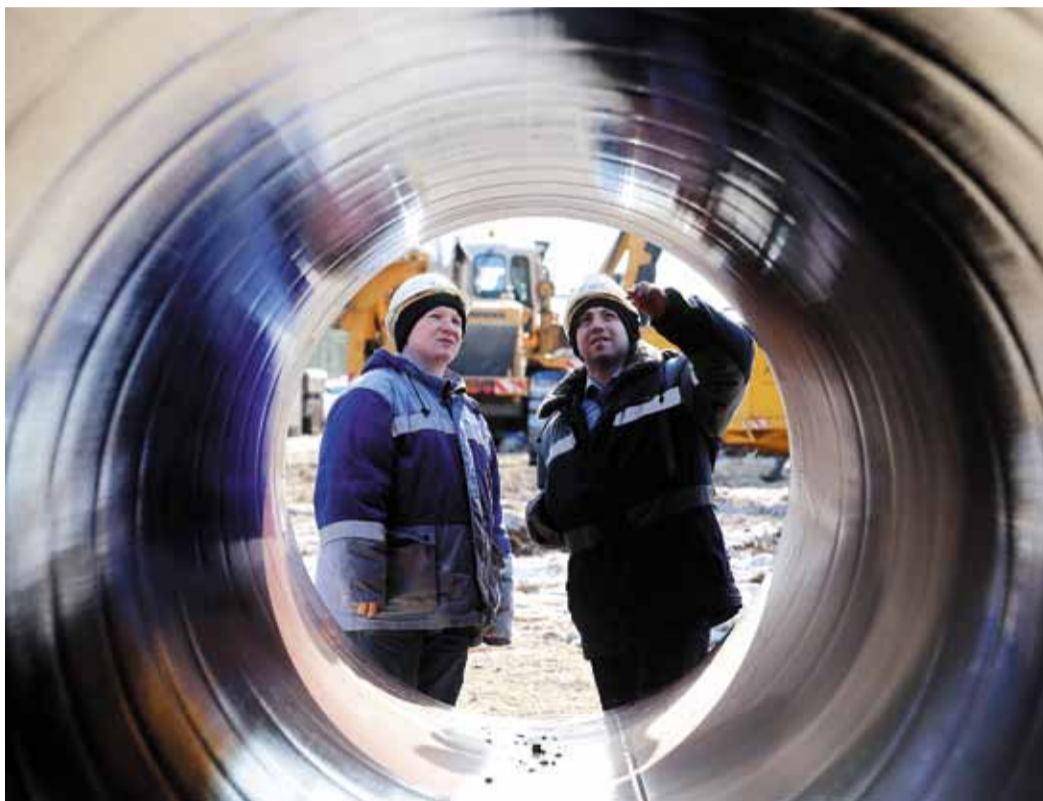
Визуальный осмотр кромки трубы на строительстве «Силы Сибири»
