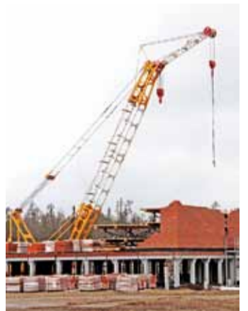
Строится здание АБК
