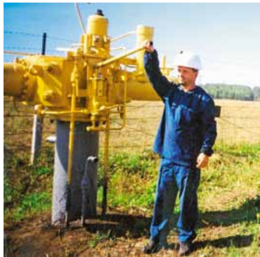
Регламентные работы на крановом узле, 2009 год
