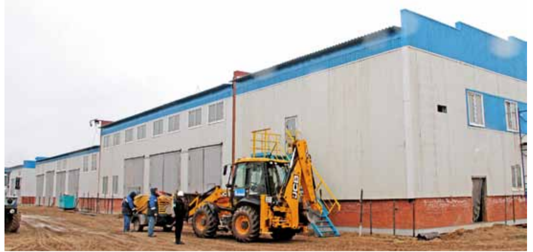
Здание ремонтно-механических мастерских уже построено
