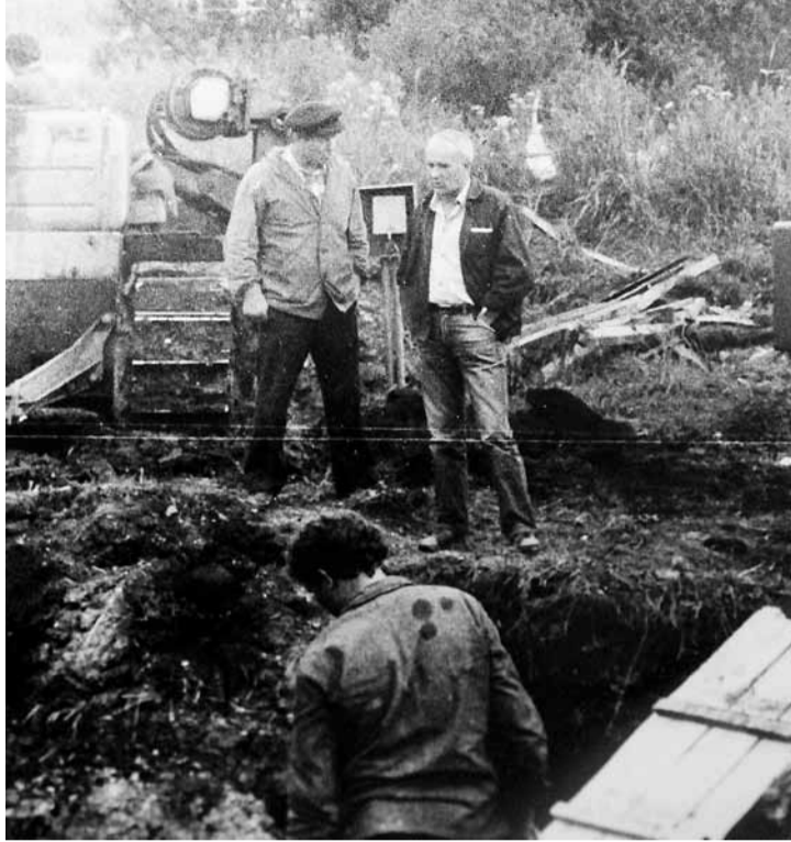
Ремонт на МГ Парабель – Кузбасс (первый слева – начальник Кемеровского ЛПУМГ с 1980 по 1992 год Г.И. Трунилин)
