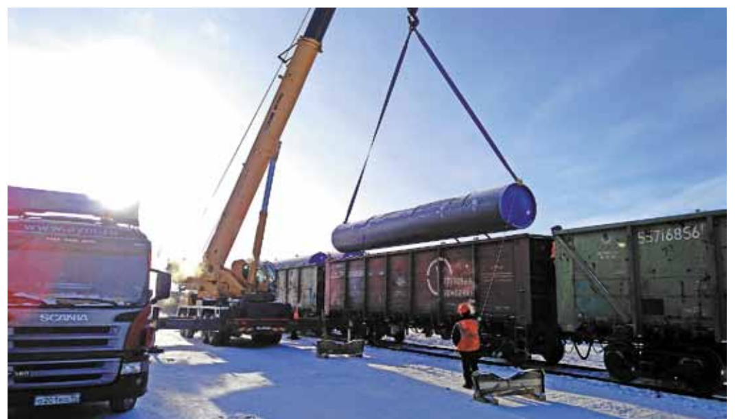
Большой объем труб для строительства магистрального газопровода «Сила Сибири» доставляется по железной дороге
