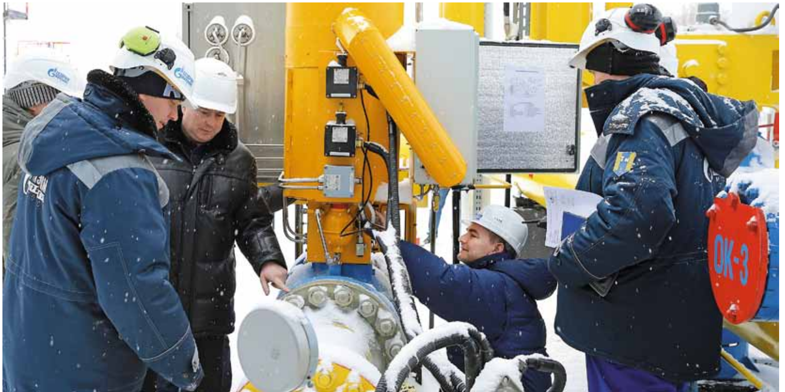
Импортозамещение в действии: антипомпажный клапан ТЭМЗа прошел испытания на КС «Просоково»
