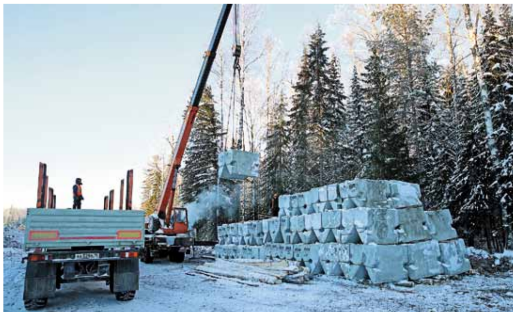
Использование пригрузов обязательно, когда газопровод пролегает в болотистой местности
