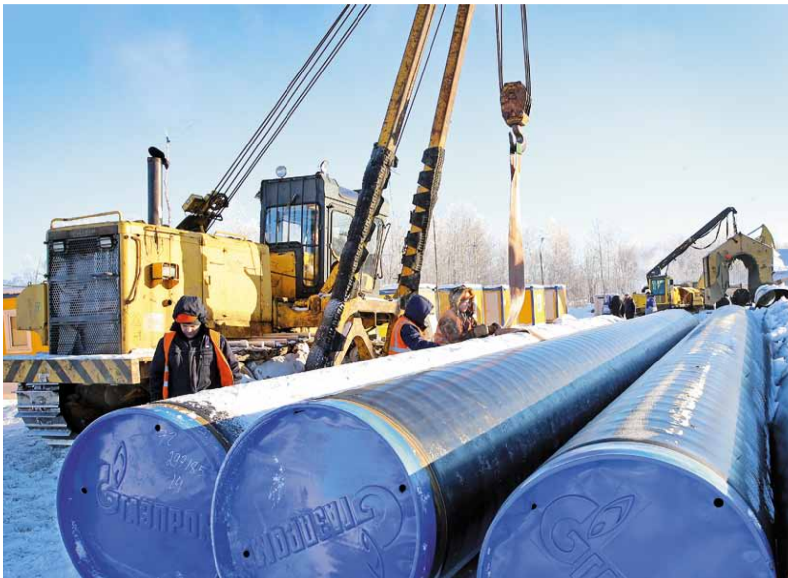
В Томском ЛПУМГ начат комплекс работ по капитальному ремонту магистрального газопровода НГПЗ – Парабель
