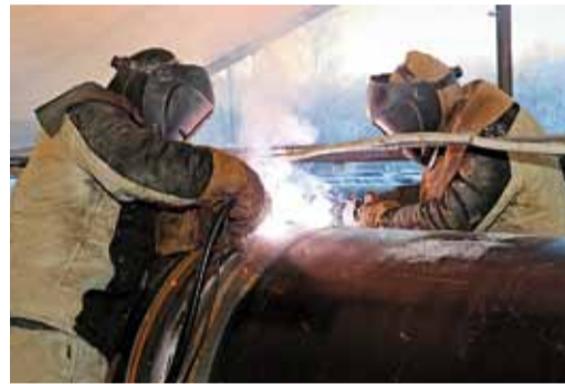
Слаженно и четко работают сварщики
