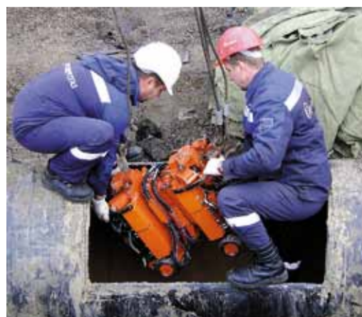
Момент помещения прибора внутрь трубы
