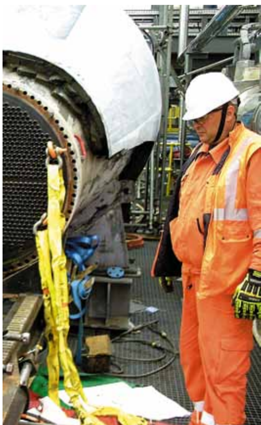
Ремонт на ОБТК – работы повышенной важности
