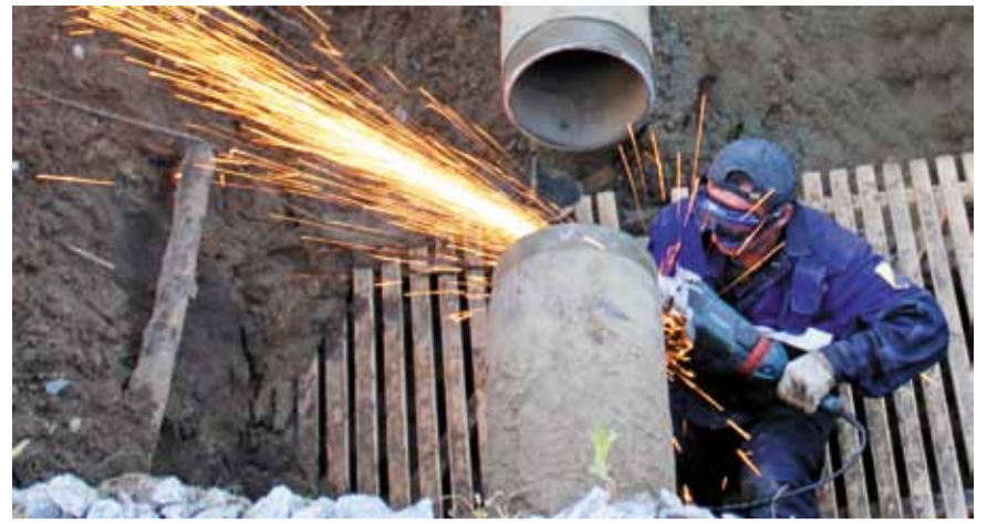
Подготовка трубы к сварке
