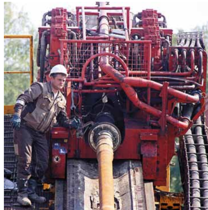
Наклонно-направленное бурение – современная технология на службе газозиков
