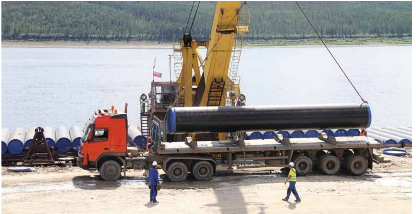
График поставки трубной продукции для «Силы Сибири» – на особом контроле заказчика строительства
