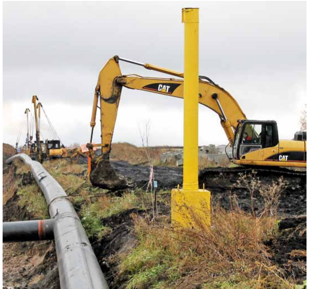
Ни погода, ни сложные трассовые условия не помешали газовикам завершить ремонт вовремя
