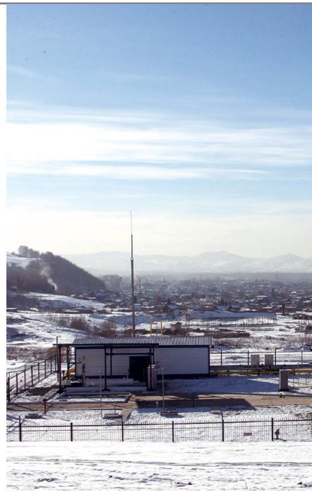
↑ Первая в Горном Алтае газораспределительная станция
