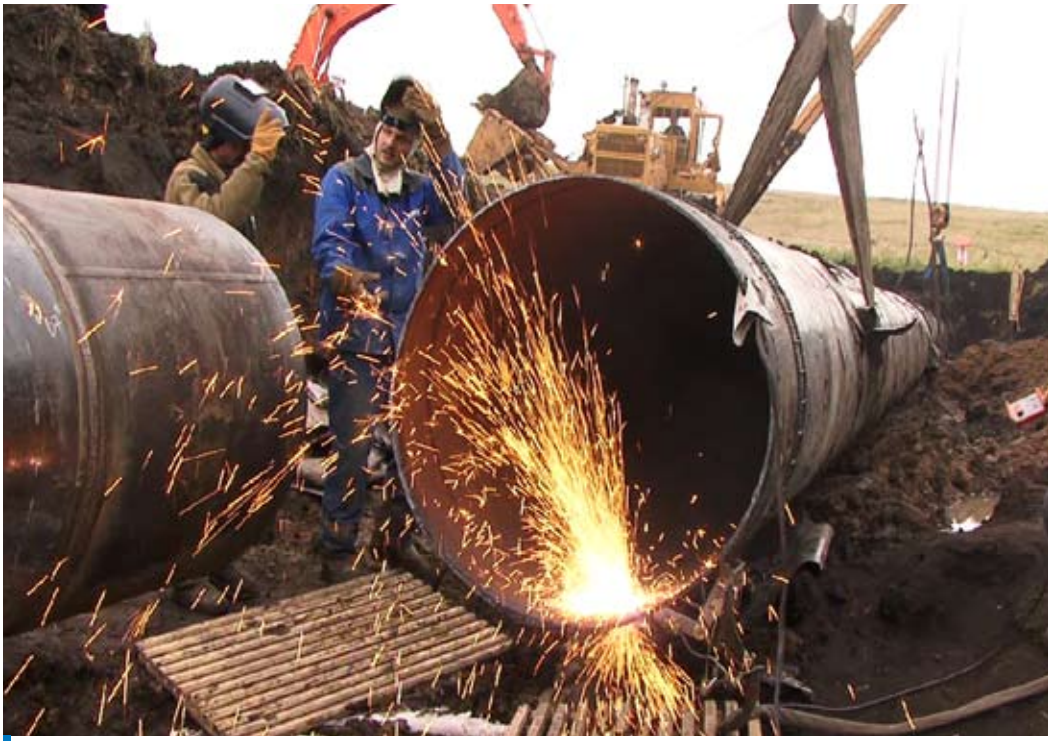
На «огневых» в Новокузнецке активно использовалась установка плазменной резки. Эта технология и другие усовершенствования с четкой организацией рабочего процесса позволили сократить время проведения работ
