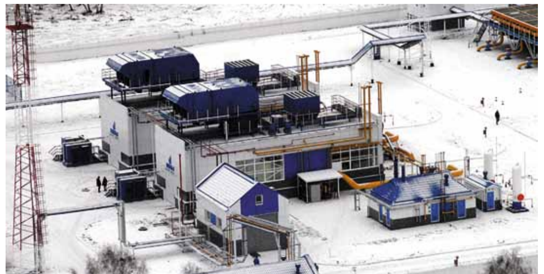
КС «Омская»: с её помощью более 1 млрд кубометров природного газа было перекачено в ЕСГ РФ из Томской газотранспортной системы
