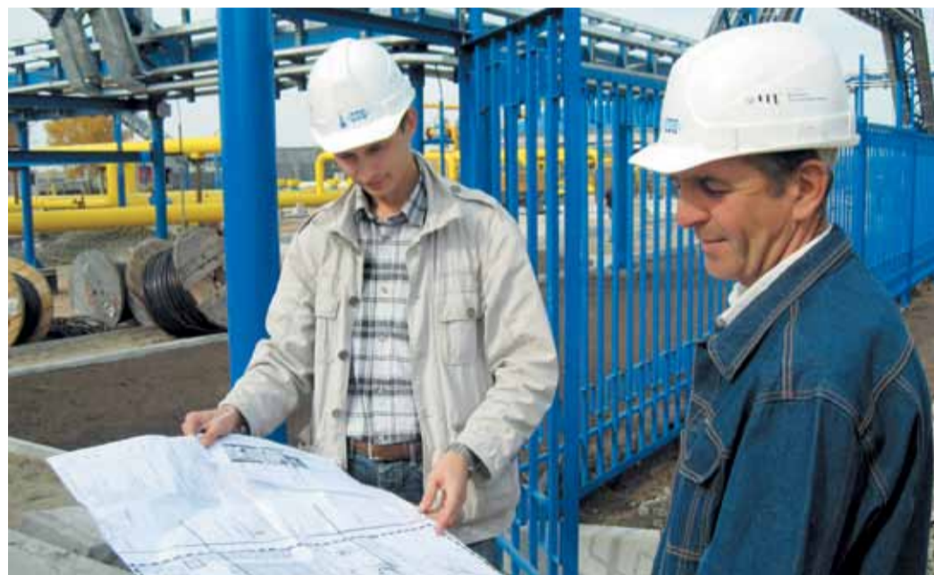
Анатолий Васюкович отремонтировал много объектов ООО «Газпром трансгаз Томск»
