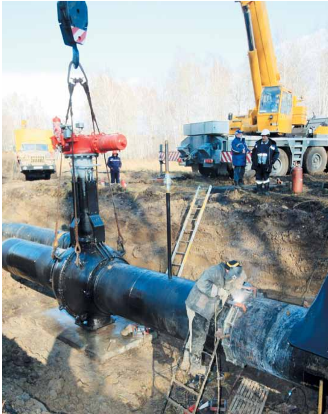
Работа УАВР на участке в районе Мельниково. Врезка кранового узла
