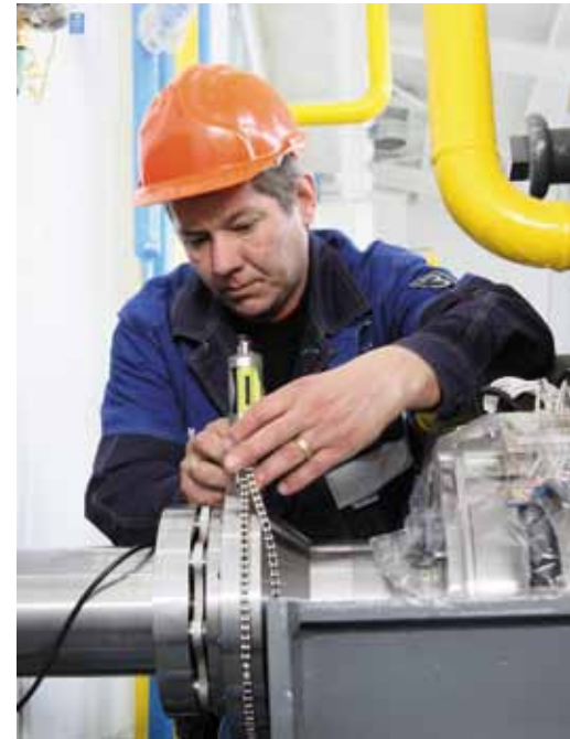
На завершающем этапе пусконаладочных работ
